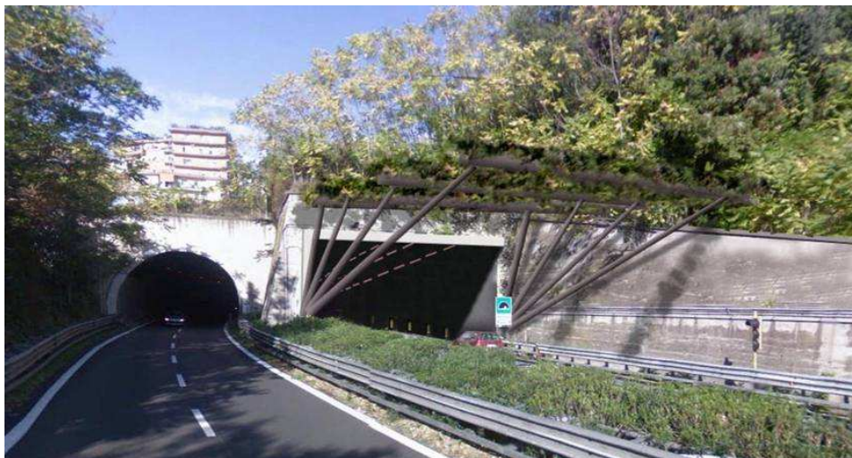
Imbocco galleria A3
