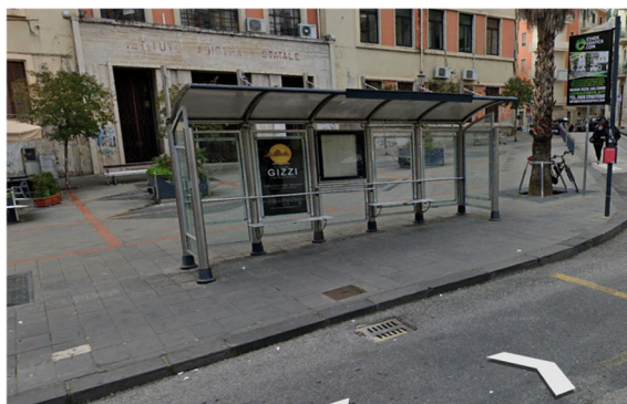
Fermata di Barriera Albertina (fonte: Google Earth)
